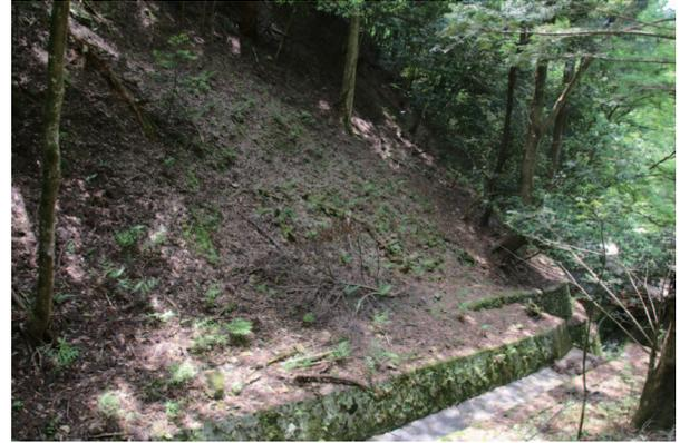
写真1 斜面法尻にコンクリート擁壁が設置され、ここで土中の空気を溜め込み空気が抜けなくなっている
